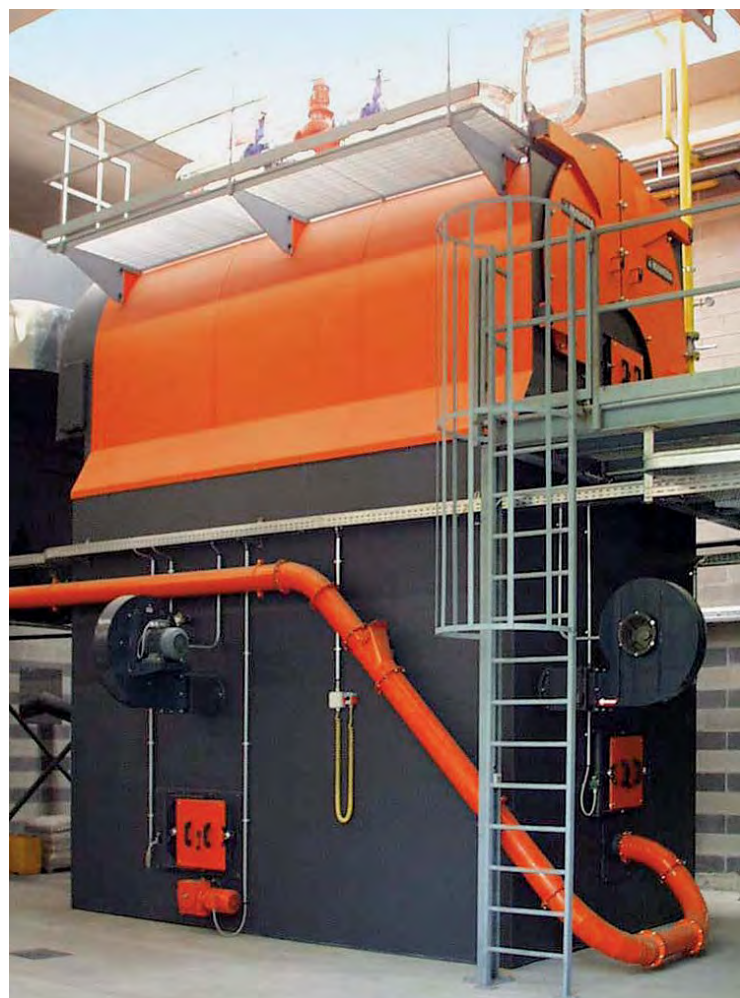
Einblasfeuerung FR 3000 Maxalto S.p.A., Novedrate, Italien (Möbelfabrik)
