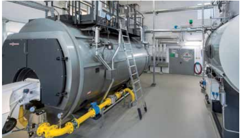
Vitamax HS mit einer Dampfleistung von 6 t/h und 10 bar Druck
