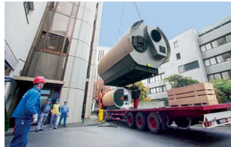
Anlieferung eines Vitomax Kessels auf der Baustelle
