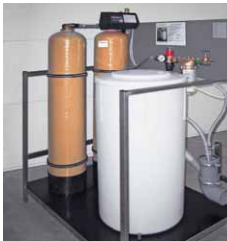
Doppel-Pendel-Enthärtungsanlage
