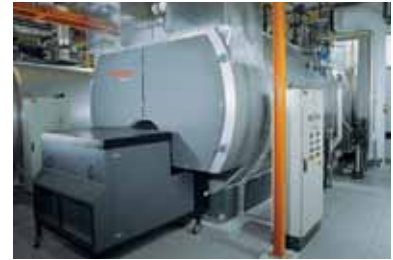
Vitomax RS Dampferzeuger mit Abhitzenutzung und Brenner
