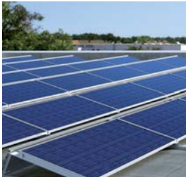
Photovoltaik-Anlage mit Vitovolt 300
